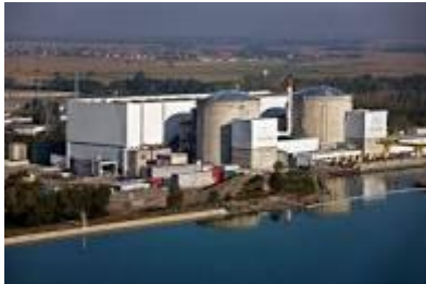
Vue de la centrale nucléaire de Fessenheim
